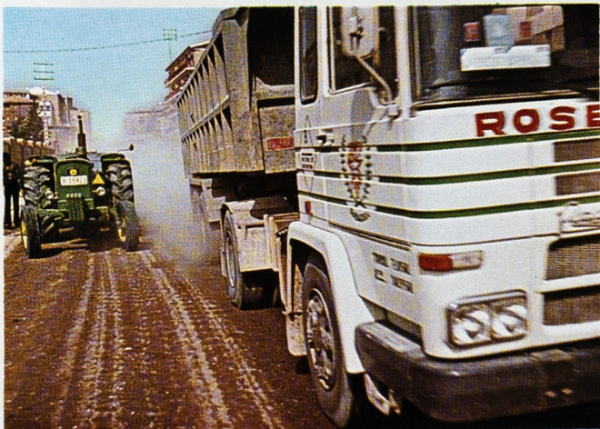
Aspecto que ofrecía la Avenida de Cristo Rey, de Vich, durante la realización del tratamiento con cloruro cálcico en forma de solución. Obsérvense las nubes de polvo que provoca el paso del camión por la zona que aún no había sido tratada.
