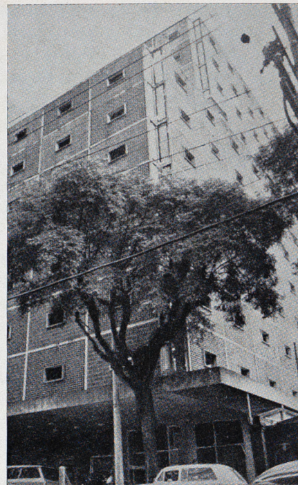
Fachada de la sede Social, co-propiedad Plavinil/Elclor en Sao Paulo (aproximadamente 13.000 m. 2 de superficie construida).
